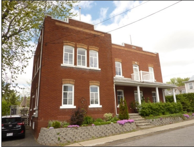
391, rue de la Fabrique
