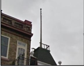
« **épi/mât** » : élément vertical prenant la forme d'un mât, qui peut être ouvragé. Il orne le faite d'un toit
