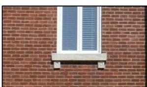
« **allège** » : partie maçonnée basse sur laquelle s'appuie une fenêtre
