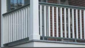
« **balustre** » : colonnettes de forme renflée généralement assemblées à d'autres colonnettes par une tablette à hauteur d'appui. Un balustre peut également désigner l'ensemble des colonnettes nommé « barrotin » qui soutient la main courante d'un garde-corps.
