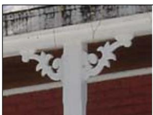
« **aisselier** » : lien de renfort, souvent courbe, portant sur une pièce verticale ou oblique et soulageant une pièce horizontale d'une charpente (entrait). L'aisselier plein est une console. Dans une galerie, pièce de bois décorative située à la jonction d'un poteau et du toit.
