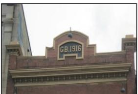
« **parapet** » : prolongement d'un mur au-dessus d'un toit plat. Le parapet est le bout de mur qui dépasse du toit, souvent au-dessus de la corniche. Il peut être tout simplement droit ou comporter une forme décorative.
