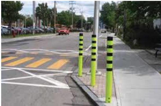
Indication des traverses piétonnières : poteaux de protection anticollisions
