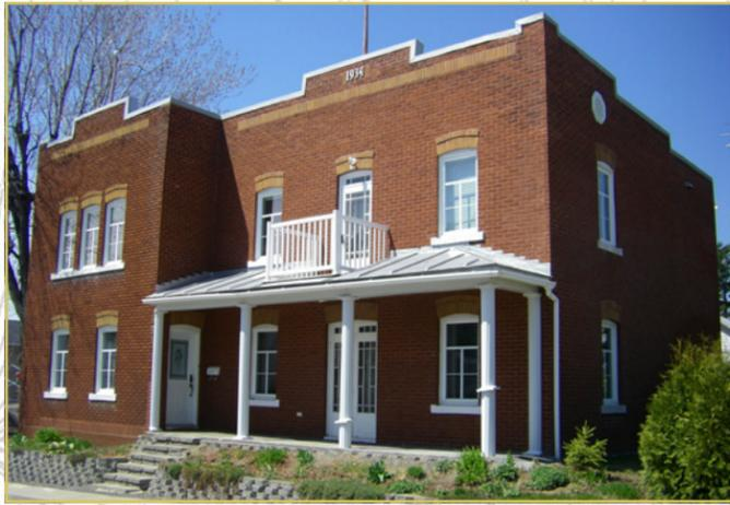
Cette maison Boomtown bâtie en 1934, représentative et bien conservée, est munie d'un parapet qui, sur les façades latérales, se termine en gradins pour suivre la pente du toit vers l'arrière (391, rue de la Fabrique).
