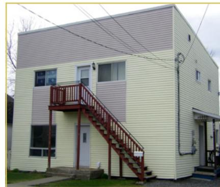
Maison complètement dénaturée par des rénovations inadéquates: ouvertures modifiées, parement de vinyle incompatible et escalier ajouté en façade.
