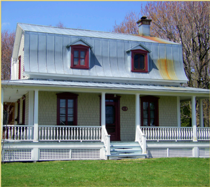
Cette maison à mansarde est entourée d'une galerie couverte sur trois côtés (665, rue Saint-Alexis).
