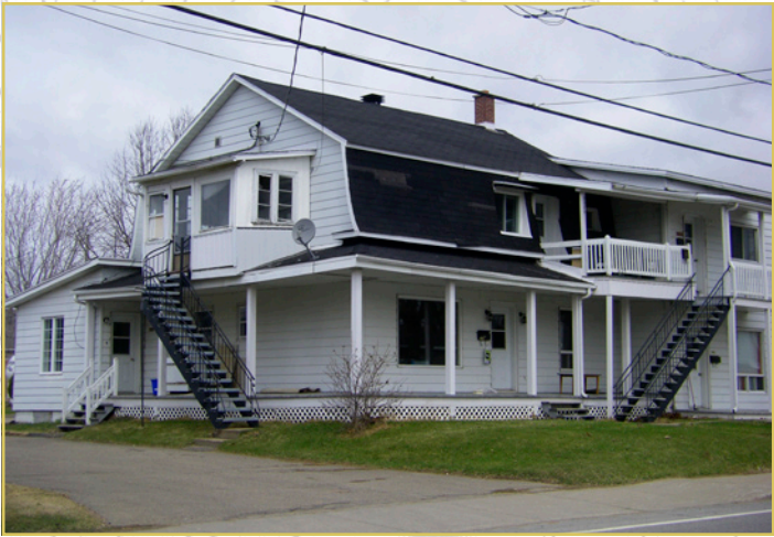
Maison à mansarde complètement dénaturée par l'ajout de volumes, d'escaliers et de balcons pour desservir des logements à l'étage. De plus, des ouvertures ont été déplacées, supprimées ou agrandies sans discernement.
