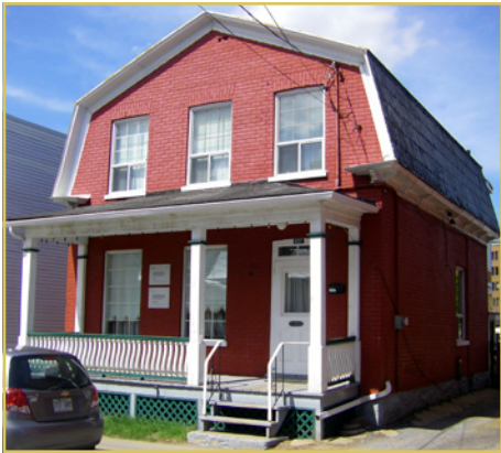
Modèle de maison à mansarde avec pignon faisant face à la rue. Ici, cet exemple est revêtu de brique et possède une galerie protégée par un auvent (602, rue Niverville).
