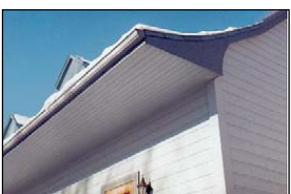
**Larmier** : saillie formée à la base d'une toiture au-dessus d'un mur, destinée à éviter le ruissellement de l'eau sur le mur. Le larmier peut être plus ou moins prononcé, recourbé ou droit. Les mots de débord de toit et avant-toit sont des synonymes de larmier.
