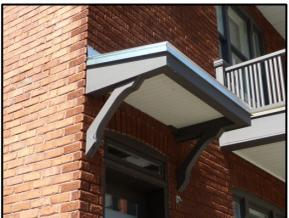
**Marquise** : structure horizontale sans appui au sol placée au-dessus d'une porte d'entrée pour servir d'abri contre la pluie. Synonyme d'abri et d'avant-toit.
