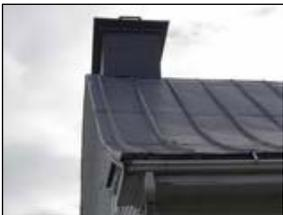
**Tôle à baguettes** : type de couverture en tôle couramment utilisée au 19<sup>e</sup> siècle. Cette technique ancienne doit son nom aux baguettes de bois sur lesquelles sont assemblés les joints des feuilles de métal. De formes variables selon les époques et les régions, ces tasseaux de bois sont disposés perpendiculairement au débord du toit et leur espacement dépend de la largeur des tôles utilisées. Ainsi, le patron varie selon la forme de toits.
