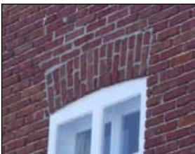
**Plate-bande en pierre ou en brique** : briques ou pierres disposées en éventail au-dessus d'une ouverture.
