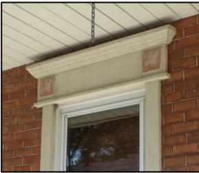
**Linteau** : pièce horizontale de bois, de pierre ou de métal qui forme la partie supérieure d'une ouverture et soutient la maçonnerie. Synonyme : poitrail.
