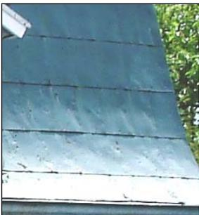
**Tôle en plaque** : semblable à la tôle à la canadienne, la tôle en plaque est constituée de rectangles de tôle cloués dans le sens de la pente du toit. Les rectangles de tôle sont généralement plus grands que ceux utilisés pour la tôle à la canadienne.
