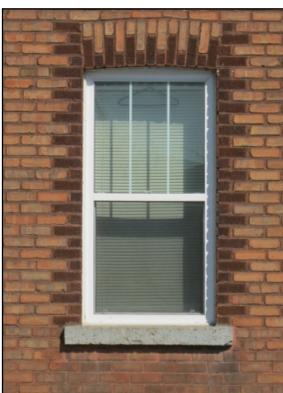
**Ouverture à arc surbaissé** : ouverture dont la partie supérieure est constituée d'un arc dont la courbure est aplatie comparativement à l'arc en plein cintre. Arc très faible.
