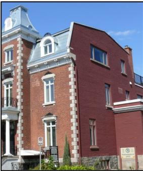
**Mur coupe-feu** : ouvrage à l'épreuve du feu, en maçonnerie, qui s'élève verticalement sur une certaine longueur et qui sert à enclore, à isoler des espaces d'un bâtiment en cas d'incendie. Dans l'architecture urbaine du Québec des 17e, 18e et 19e siècles, mur mitoyen en maçonnerie se poursuivant au-dessus des toits pour contrer la propagation des incendies.
