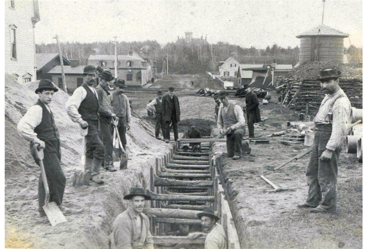
Travaux d'égouts vers 1895
