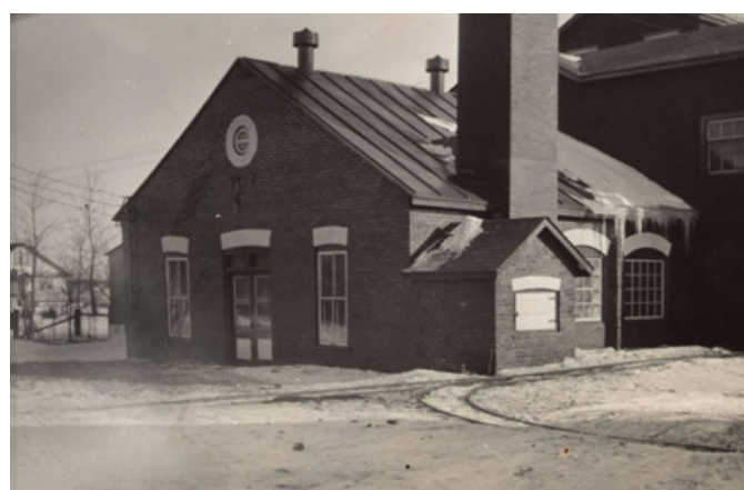
46. Vue rapprochée de l'un des bâtiments du complexe de Red Mill. Source : Collection Marthe Bradley.
