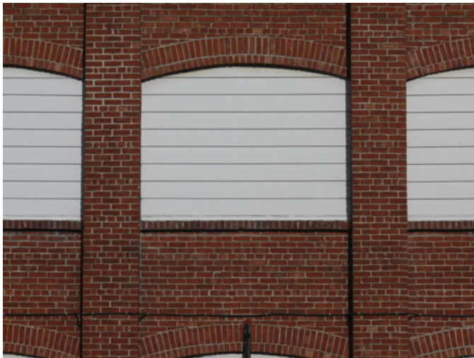
93. Platebandes en brique au-dessus des ouvertures cintrées et pilastres de l'ancienne Sterling Shirts & Overalls Co (centre communautaire des loisirs Jean-Noël Trudel, 55, rue Mercier).
