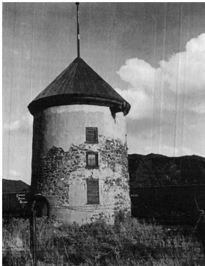
2. Le moulin de la Commune est reconstruit en 1781 sous la forme d'une tour en pierre cylindrique de quatre étages, coiffée d'un toit conique. Originellement situé à proximité du fleuve Saint-Laurent, le moulin a été déménagé en 1975 sur le campus de l'Université du Québec à Trois-Rivières. Source : BAnQ, 783-54. Photo : J.-W. Michaud, 1954.
