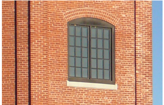
86. Ouverture cintrée dotée de petits carreaux sur l'ancienne usine de filtration de la CIP (Boréal).
