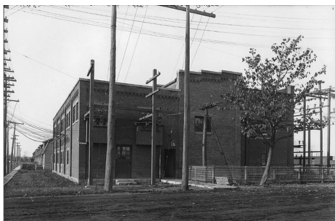
27. Le poste électrique sis au coin des rues Saint-Paul et Saint-Maurice (disparu). Source : Musée McCord.
