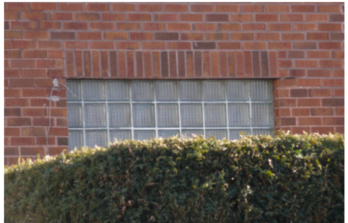
91. Ouverture munie de blocs de verre de l'étage de l'ancienne Lavolette Potato Chips, rue Sainte-Angèle.
