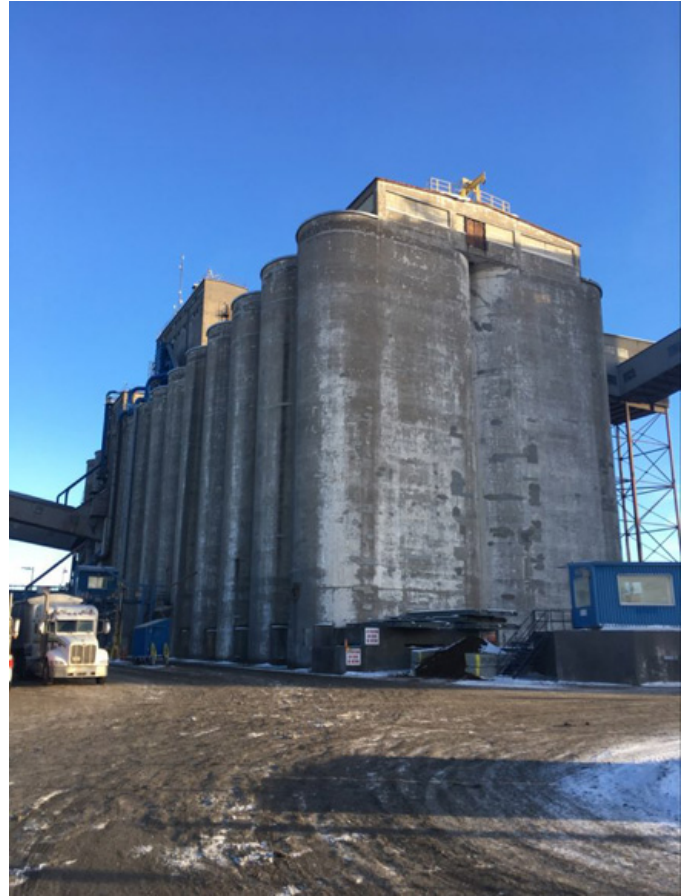
67. Élévateurs à grains du port de Trois-Rivières construits à partir de 1936.
