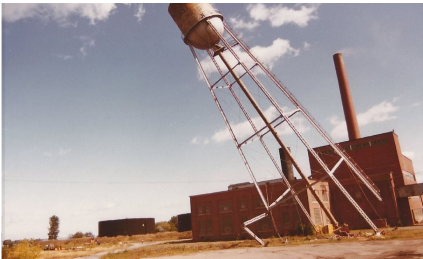
109. Démolition du château d'eau de l'ancienne St. Maurice Paper à Cap-de-la-Madeleine. Sa cheminée est toutefois toujours debout. Source : Souvenirs madelinois & marthelinois. Facebook.
