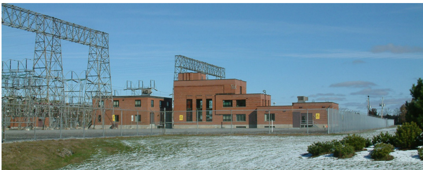
29. Poste de la Shawinigan Water and Power (aujourd'hui Hydro-Québec) du boulevard des Chenaux construit en 1937, puis agrandi en 1951 et 1971. Photo : Patri-Arch, 2009.
