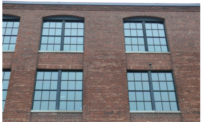
96. Platebandes en brique et jeux de briques formant une corniche sur les façades de l'édifice Lampron, 1610, rue Bellefeuille.
