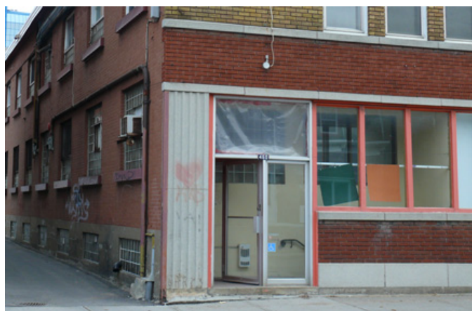
101. Insertions en béton formant des bandeaux et des pilastres crénelés dans la devanture de l'ancienne Regent Shirts Factory, 438-460, rue Saint-Georges.
