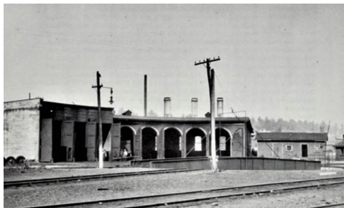
48. La rotonde du Canadien Pacifique à Trois-Rivières démolie vers 1973. Source : Edward Forbes Bush. Engine Houses and Turntables on Canadian Rail . Boston, Boston Mills Press, 1991, p. 54.
