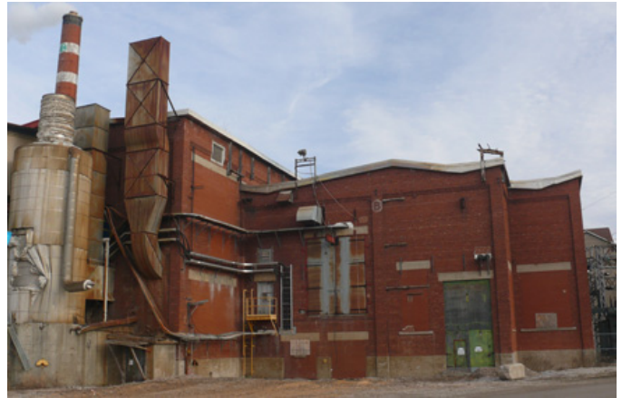
83. Section ancienne en brique de l'un des bâtiments de la Kruger-Wayagamack. Certains éléments d'ornementation sont même encore présents sur les bâtiments originaux.
