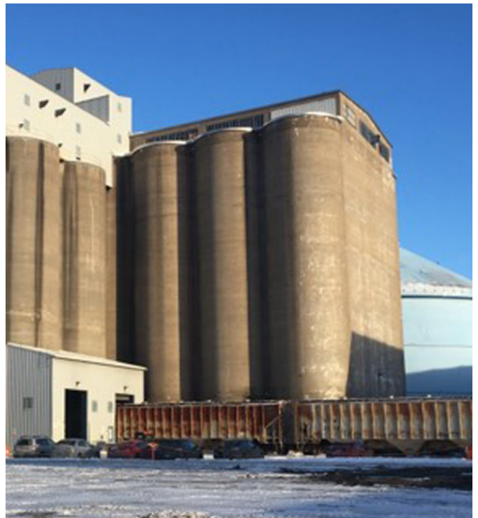
84. Le béton armé est très polyvalent et permet de créer des formes arrondies comme ici aux élévateurs à grains du Port de Trois-Rivières.
