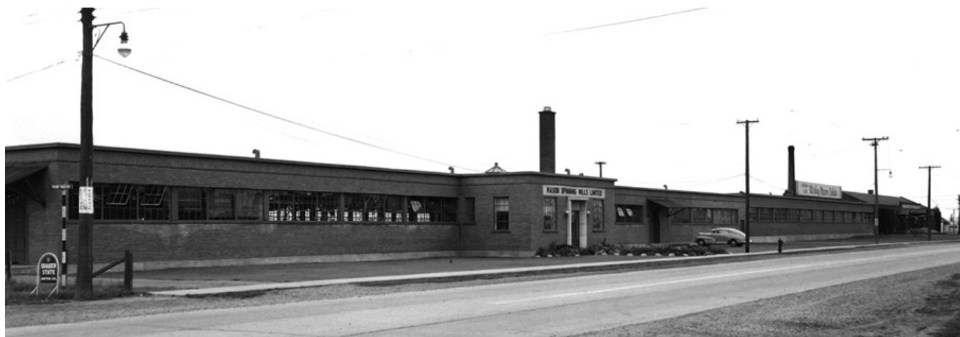
79. Le bâtiment de la Tooke Brothers (actuel 165, boulevard Sainte-Madeleine) possède un profil bas qui s'étire en un seul étage sur toute sa superficie. Source : BAnQ.
