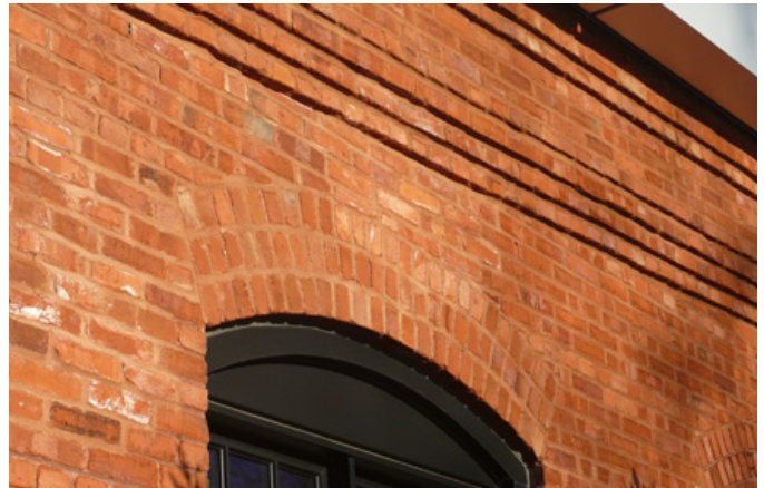
95. Platebandes en brique cintrées et jeux de briques formant une corniche sur l'ancienne usine de filtration de la CIP (Boréal).
