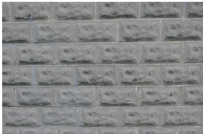
102. Blocs de béton moulés présentant un bosselage décoratif sur les façades des Forges de la Salamandre, 300, chemin de l'Île-Saint-Christophe.
