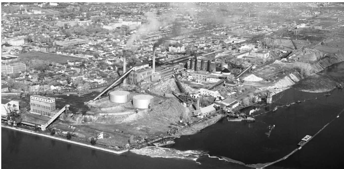
20. L'imposante Canadian International Paper (CIP) sise à l'embouchure de la rivière Saint-Maurice, photographiée dans les années 1950-1960. Source : BAnQ.
