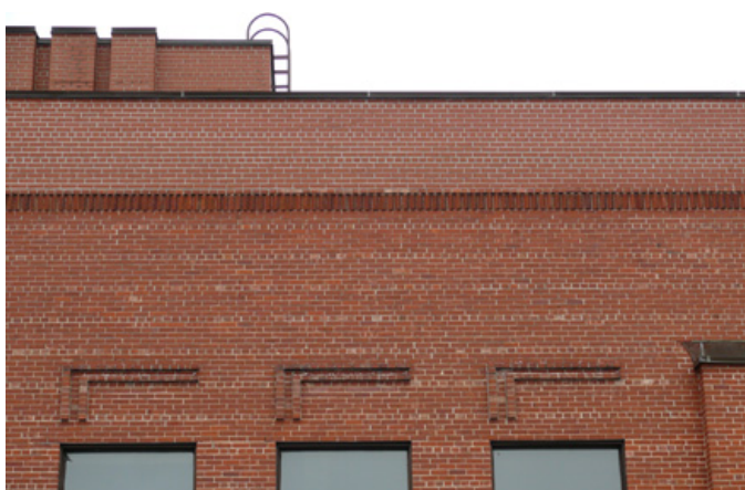
99. Jeux de briques d'influence Art déco sur les façades du poste d'Hydro-Québec de Trois-Rivières, 5900, boulevard des Chenaux.
