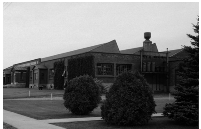
88. L'usine de la Tooke Brothers, boulevard Sainte-Madeleine, possède des puits de lumière (sheds) sur sa toiture pour apporter davantage de luminosité à l'intérieur. Source : BAnQ.
