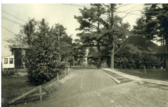
115. Les maisons des employés cadres de la Wayagamack Pulp and Paper (démolies) sur l'île La Poterie. Source : Boréalix.
