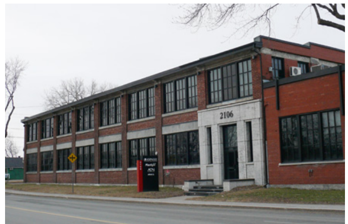
87. L'ancienne manufacture George Christie Wire Works, rue Bellefeuille, est caractérisée par son généreux fenêtrage qui occupe une large part de ses façades.
