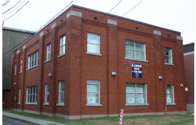
94. Cette section de l'ancienne École de papeterie (Waste Paper Products, 2250, rue Saint-Olivier), possède des façades dotées de jeux de briques et de pilastres surmontés de chaperons en béton.
