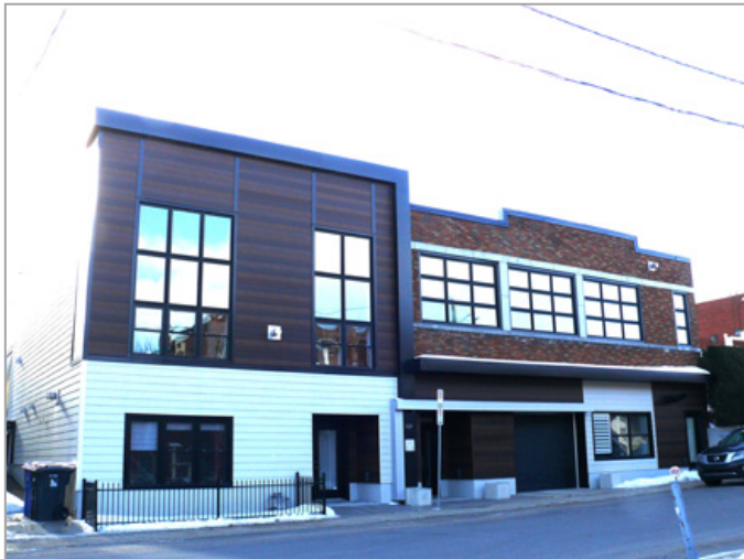
58. L'ancienne Laviolette Potato Chips, sise au 521, rue Saint-Angèle, a été convertie en immeuble résidentiel en copropriété.
