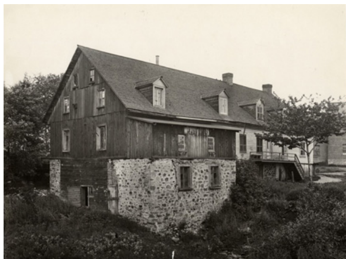
3. Le moulin à eau du Cap-de-la-Madeleine (démoli) autrefois situé près de la rue Notre-Dame Est et du Sanctuaire de Notre-Dame du Cap. Un parc et une rue rappellent la présence de ce moulin. Source : BAnQ.
