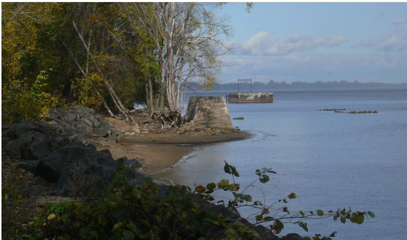
69. Vestiges de quais dans le fleuve Saint-Laurent ayant servi à l'ancienne papeterie St. Maurice Paper de Cap-de-la-Madeleine.
