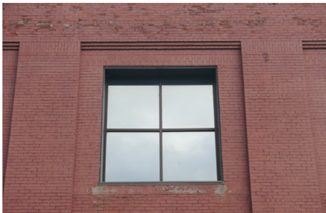
97. Platebandes, pilastres et jeux de briques sur les façades de l'ancienne St. Maurice Paper, 702, rue Notre-Dame Est.
