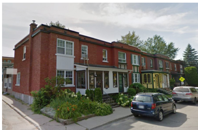
118. Ensemble de huit maisons en rangée, au 785 à 819, rue Saint-Paul, construit en 1920-1922 pour loger des employés de la St. Maurice Lumber. Source : Google Street View, 2012.
