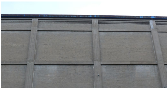
84. Hangar n° 1 du Port de Trois-Rivières doté d'une ossature en béton armé apparente à l'extérieur. Les interstices entre les poutres et colonnes en béton sont remplis de briques.
