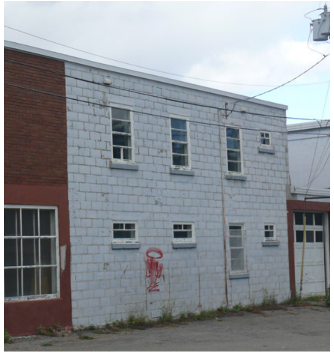
85. Mur constitué de blocs de béton structural à la Quincaillerie Massicotte au 572, rue Notre-Dame Est.
