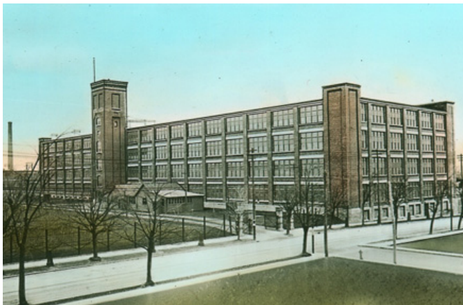
85. L'ancienne filature Wabasso (disparue) du boulevard du Saint-Maurice était l'exemple par excellence de murs extérieurs presque entièrement vitrés permettant aux travailleurs répartis sur les quatre étages de profiter d'un maximum de lumière naturelle. Source : Musée McCord.
