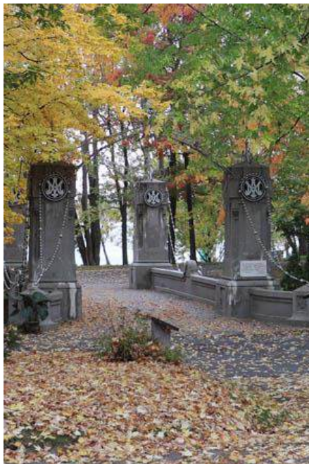
Pont des Chapelets, rue Notre-Dame Est (jardins du Sanctuaire)
