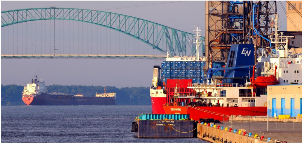
Figure 12. Secteur industriel portuaire
