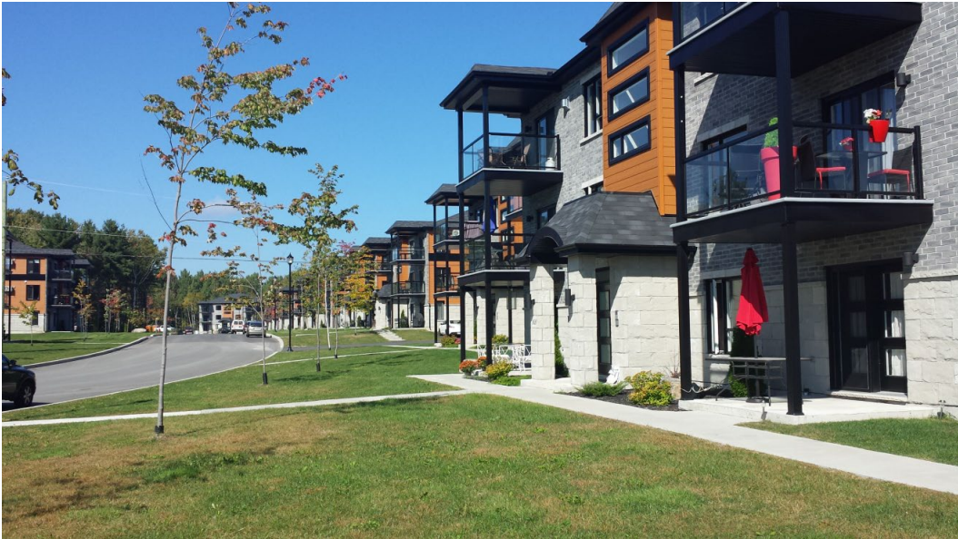
Photo : Ville de Trois-Rivières
