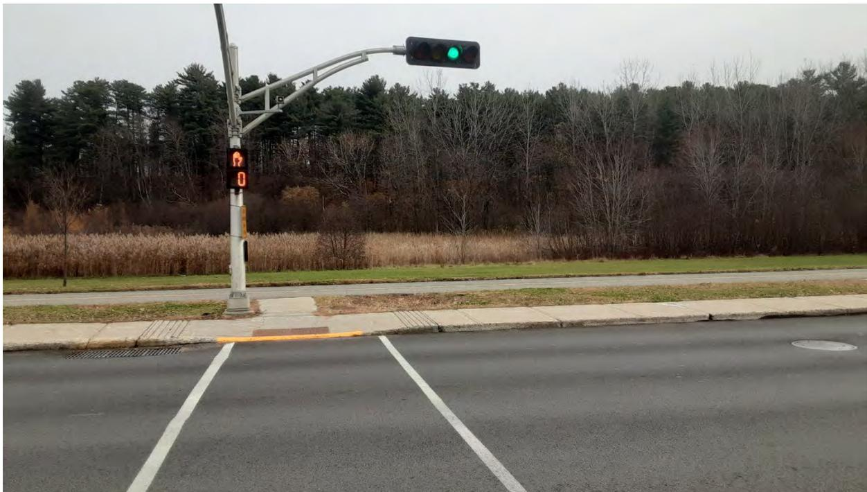
Figure 45 : Plaques podotactiles à une intersection munie de feux sonores
