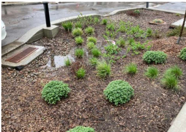
Figure 32 : Avancée de trottoir drainante (saillie drainante)
