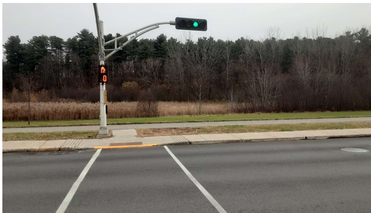
Figure 46 : Plaques podotactiles à une intersection munie de feux sonores
