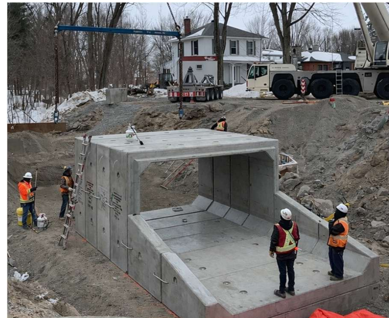
Nouveau ponceau en construction
