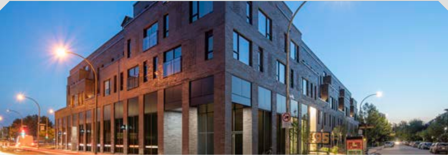
Résidentiel & commercial Avenue Beaumont, Montréal 495 Beaumont Architectes : Sid Lee Architecture
