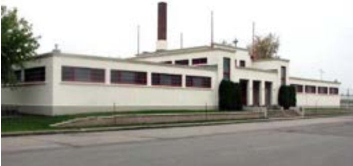
Pavillon de la piscine du parc de l'Exposition
